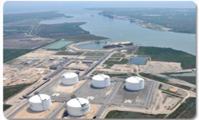
Sabine Pass LNG Facility
